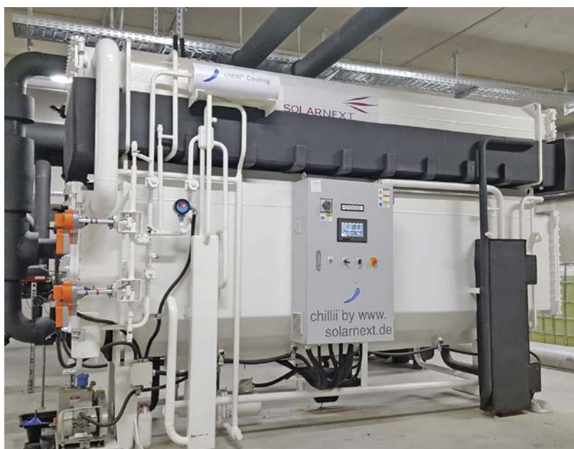
Im Quartier Bahnhof Nord in Rosenheim installierte Absorptionskälteanlage „chillii® Cooling Kit“ der SolarNext AG.
