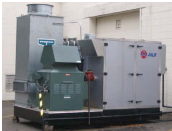
Abb. 5: Flüssigsorptionssystem OA-6000 mit Kühlturm der Firma AIL Research Inc (Quelle: AIL Research)
