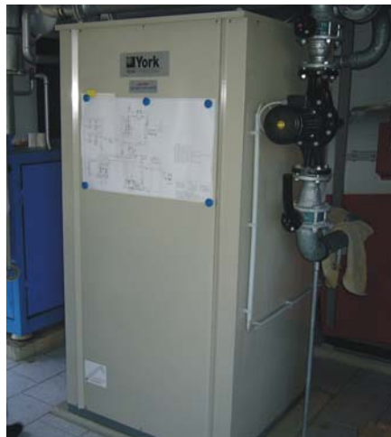
Abb. 2: Wasser/Lithiumbromid Absorptionskältemaschine WFC-10 der Firma Yazaki (Quelle: SolarNext)
