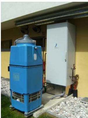
Figura 2: Macchina frigorifera ad assorbimento ad ammoniac/acqua chillii® PSC10 con torre di raffreddamento tramite evaporazione
