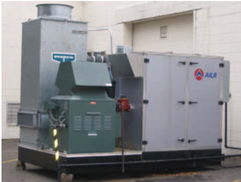
Figura 6: Sistema a desiccante liquido OA-6000 con torre di raffreddamento della AIL Research Inc (Fonte: AIL Research)
