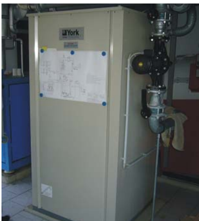
Figura 1: Macchina frigorifera ad assorbimento ad acqua/bromuro di litio WFC-10 della ditta Yazaki (Fonte: SolarNext)
