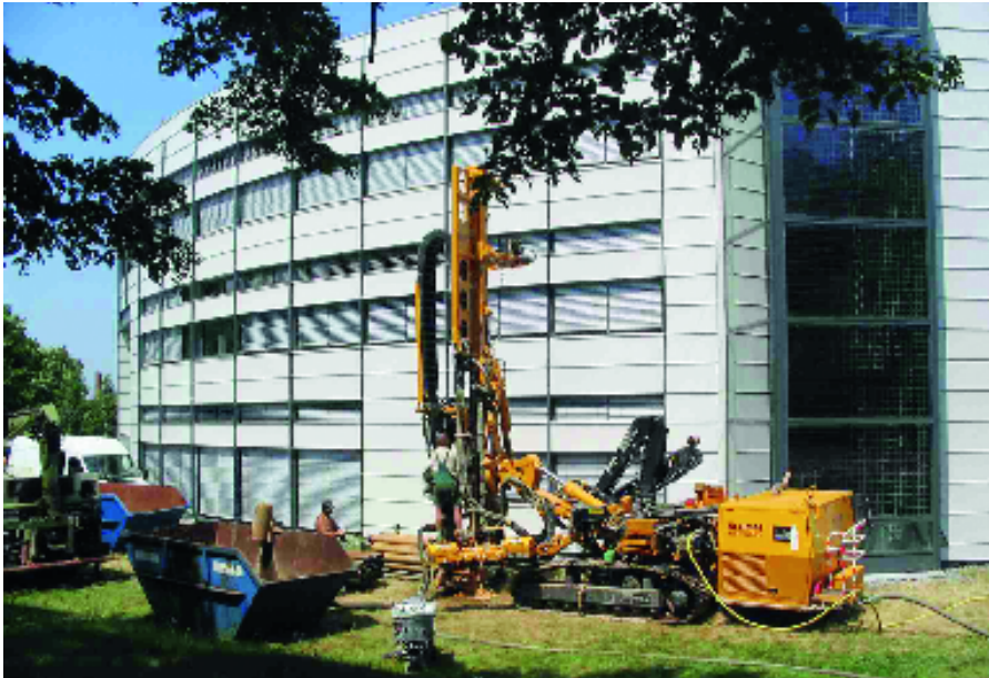
Foto: Fraunhofer ISE
